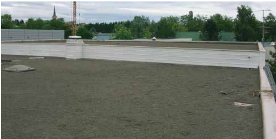
Etanchéité de toiture : membrane Sarnafil® TG
